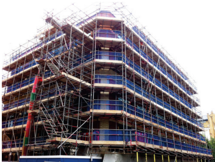
Obra em Londres, junho de 2015 (Bermondsey)
