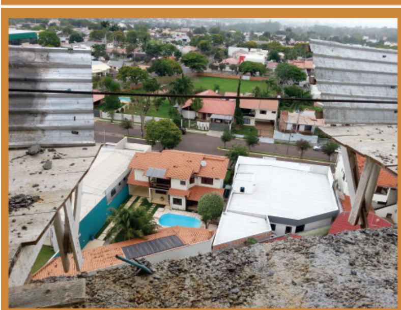
Exemplos de bandejas (plataformas de proteção) e interações entre trabalhadores e bandejas, como montagem e manutenção
