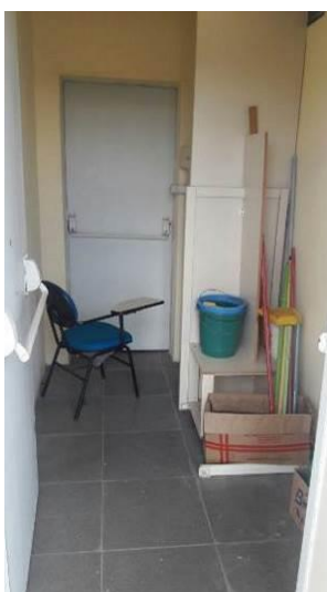
Figura 33 – Saída de Emergência utilizada como depósito
