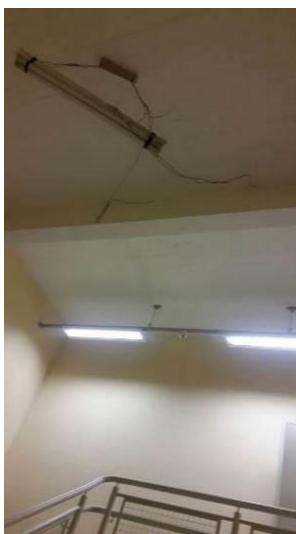
Figura 32 – Iluminação com defeitos na saída de emergência do prédio Cotada
