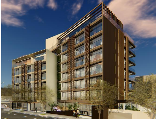
Figura 03. Fachada principal da edificação com brises nas varandas.
