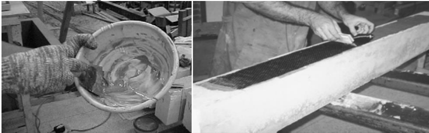
Figura 6: Colocação da manta de fibra de carbono
