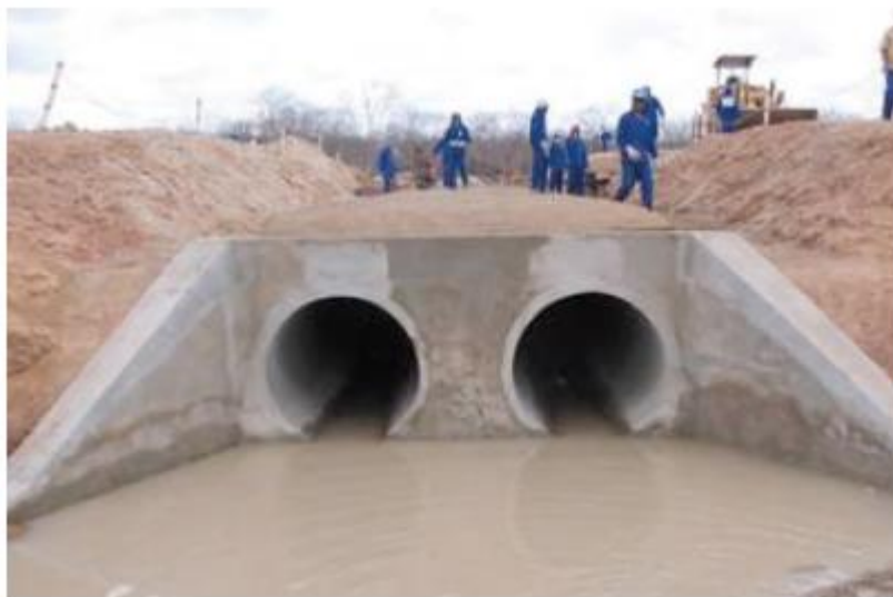
Figura 10 – Travessia para transposição de corpo d'água. Foto: Fátima Chagas.
