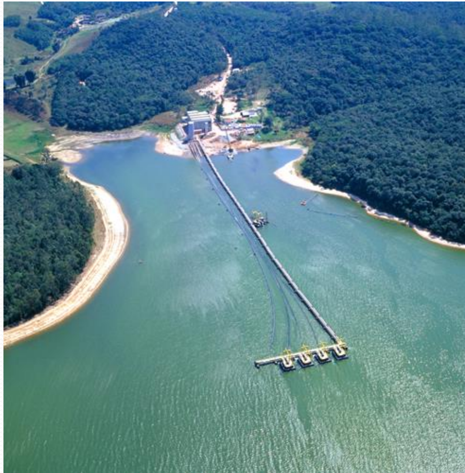
Captação flutuante Represa Billings (Taquaquecetuba – SP)
