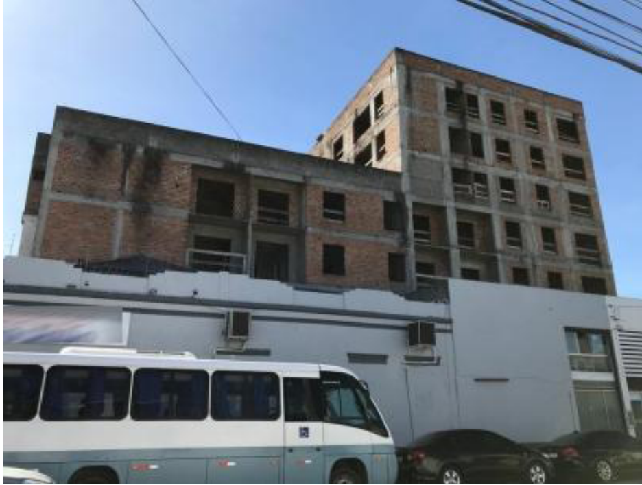
Figura 1 Edifício inacabado no município de Pelotas/RS
