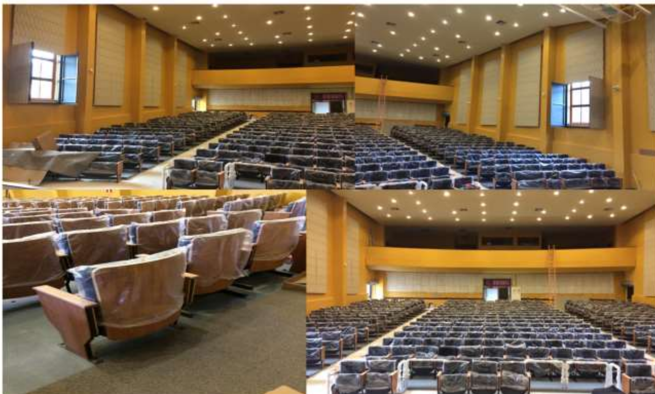
Reestruturação acústica e readequação do mobiliário Instalação de novo revestimento no piso
