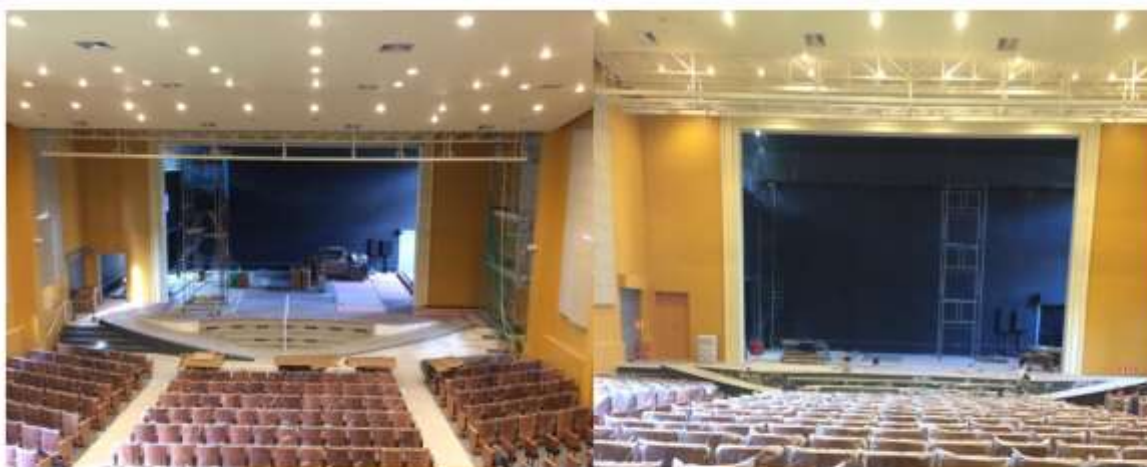
Reestruturação: Rede elétrica e iluminação Palco e Acessibilidade
