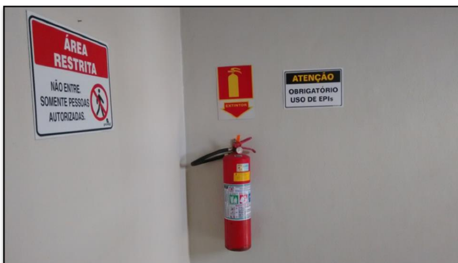
Figura 10 - Instalação de extintores e placas de sinalização e emergência. Fonte: Autor
