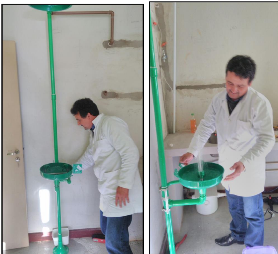
Figura 11 - chuveiro de emergência e lava olhos. Fonte: Banco de dados do LÂMINA
