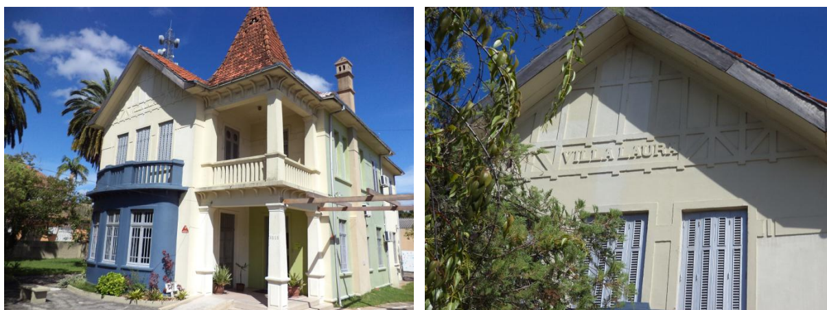
Figura 13: Vila Laura. Na imagem à esquerda: A fachada da residência. Na imagem à direita: Detalhe da fachada com a imitação do enxaimel. Fonte: Fotos da autora, 2013.
