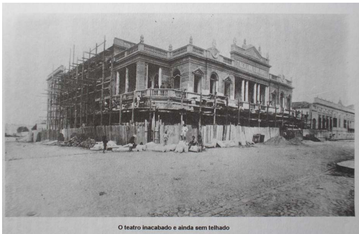
Figura 8 - Teatro Guarany em obras. 1920. Prédio onde foi aplicado cimento penteado na fachada. Foto em: CALDAS e SANTOS (1994; p. 25)
