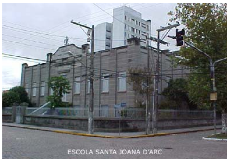
Figura 9 – Escola Santa Joana D'arc. Exemplo de prédio com cimento penteado em Rio Grande. Foto: http://www.riograndeemfotos.fot.br
