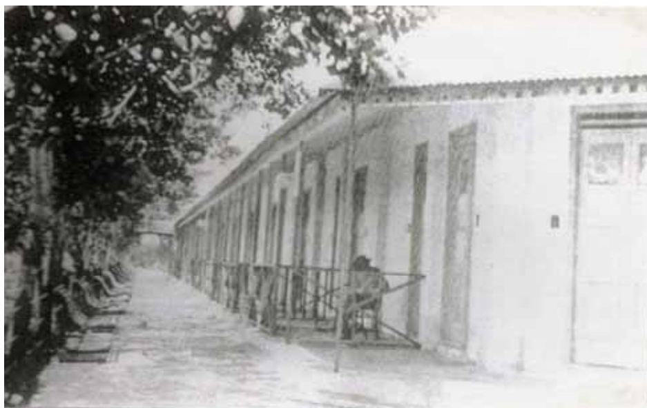
Figura n°. 05 – Exterior dos quartos do hotel em frente a Rua da República. Ao fundo a passarela de acesso aos salões de refeições e festas.
