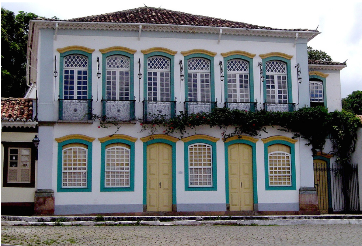
Figura 11: Na imagem: Sobrado luso-brasileiro que apresenta beiral saliente em beira sob beira, São João Del Rei, MG. Posteriormente, a edificação recebeu calha metálica Fonte: O maior acervo de arquitetura colonial do Brasil. Disponível em: < http://www.skyscrapercity.com/showthread.php?t=493115 > Acesso em: 2010/07.
