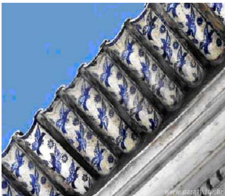
Figura 10: Na imagem à esquerda, 1: Exemplo de beiral em beira sob beira e janela de arco abatido abatido. Na imagem à direita, 2: Beiral apoiado em cornijas salientes, Paraty. Fonte: Disponível em: < http://www.paraty.tur.br/historia/arquitetura_colonial.php > Acesso em: 2010/05.
