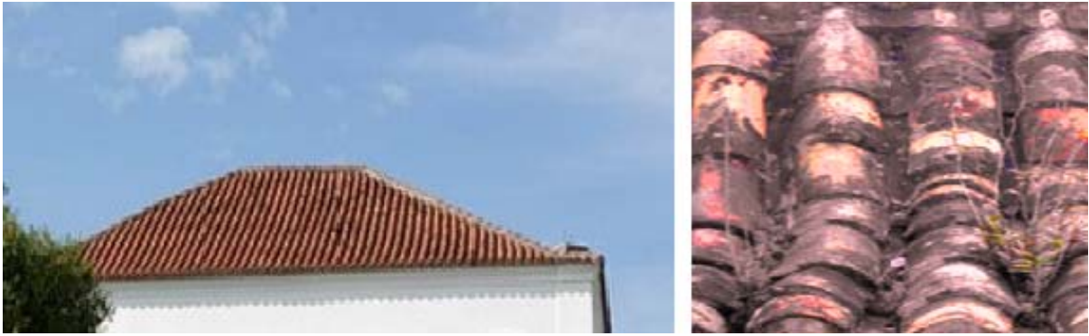
Figura 25: Na imagem à esquerda, 1: cobertura em quatro três águas do telhado, com beiral em beira sob beira. Na imagem à direita, 2: Telhas de capa e canal. Fonte: Fotos da autora, 2011.
