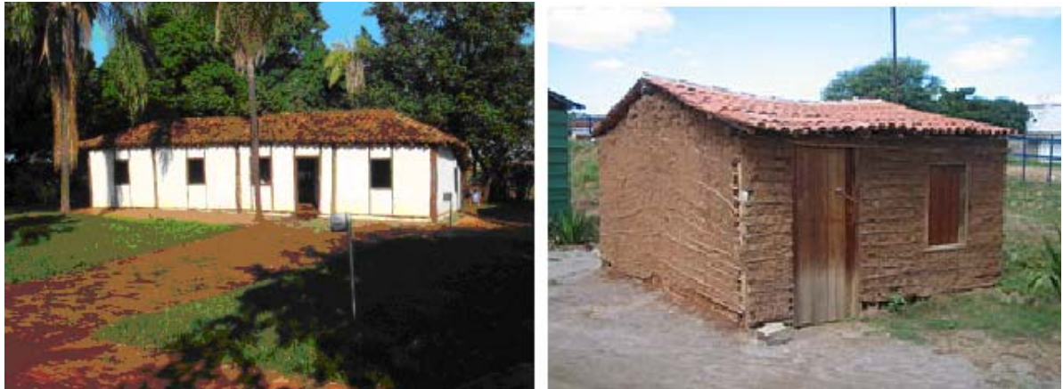
Figura 6: Na imagem à esquerda, 1: Exemplo de casa de Taipa, MG. Na imagem à direita, 2: Casa de pau-a-pique, Serra Talhada, PE. COUTO, José Alberto Ventura & PINETTI, Cíntia Cristina Hirato. Análise das Patologias de Técnicas Construtivas Patrimoniais no Estado do Mato Grosso do Sul. Disponível em: < http://www.propp.ufms.br/gestor/titan.php?target=openFile&fileId=526 > Acesso em: 2010/06.
