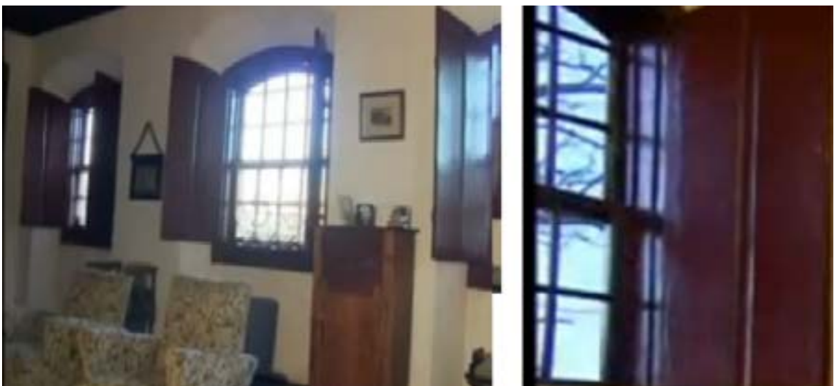
Figura 28: Na imagem à esquerda, 1: As janelas de guilhotina e os escuros de duas folhas das aberturas do sobrado. Na imagem à direita, 2: As folhas dos escuros com dobras. Fonte: Fotos da autora, 2010.
