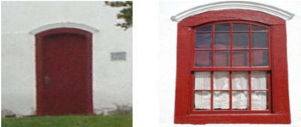
Figura 27: Na imagem à esquerda, 1: As pestanas sobre os arcos abatidos das vergas da porta do pavimento térreo. Na imagem à direita, 2: As pestanas das as janelas do pavimento térreo. Fonte: Fotos da autora, 2011.
