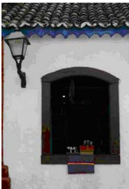
Figura 10: Na imagem à esquerda, 1: Exemplo de beiral em beira sob beira e janela de arco abatido abatido. Na imagem à direita, 2: Beiral apoiado em cornijas salientes, Paraty. Fonte: Disponível em: < http://www.paraty.tur.br/historia/arquitetura_colonial.php > Acesso em: 2010/05.
