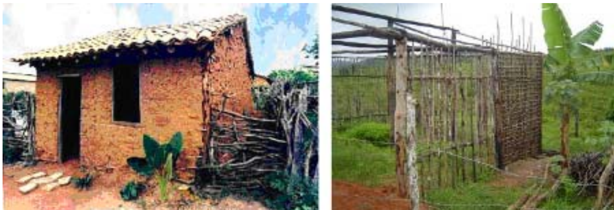
Figura 7: Na imagem à esquerda, 1: Casa de pau-a-pique, Ipiáú, BA. Na imagem à direita, 2: Armação para montagem da edificação em pau-a-pique. Fonte: Olhares e Vivências Bioecológicas. Disponível em: < http://canrobertalmeida.multiply.com/photos/album/28/28#photo=9 >. Acesso em: 2010/02.
