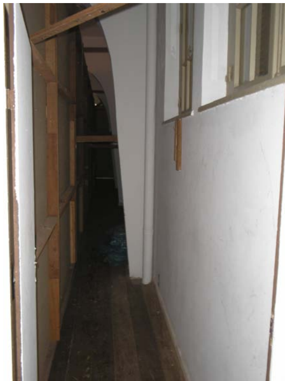
Imagem 32: Vista posterior das paredes falsas
