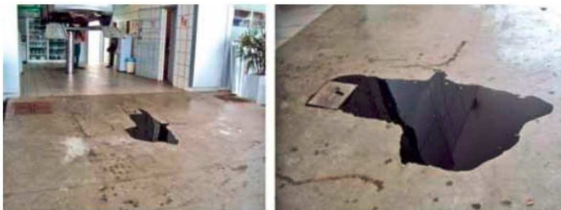
Figura 3: Reservatório subterrâneo de óleo usado extravasa e o óleo se espalha pela pista de abastecimento.
