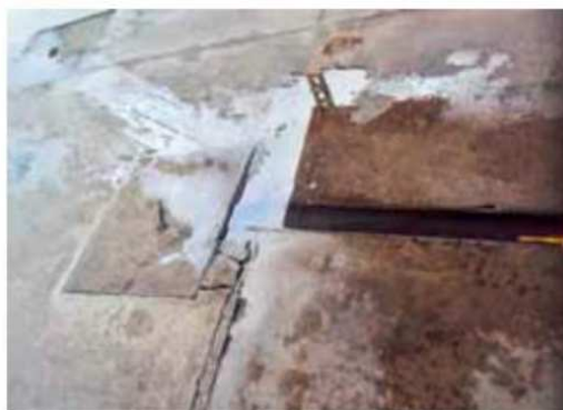
Figura 4: Caixa separadora de água e óleo atinge capacidade limite e extravasa o efluente contido.
