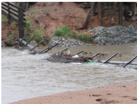
Figura 9: Estrutura de ponte no interior do município em risco devido à erosão em 2016.
