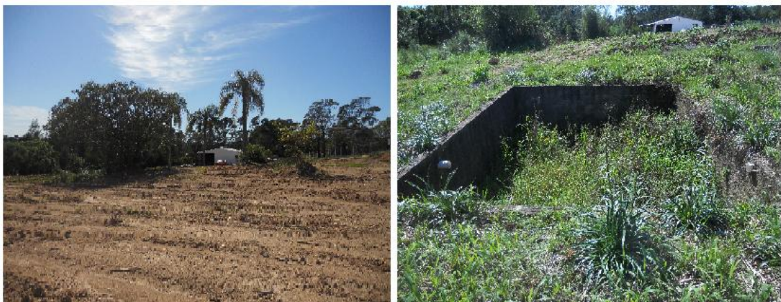
Figura 12- Área utilizada como aterro controlado (12a) e tanque de tratamento (12b).
