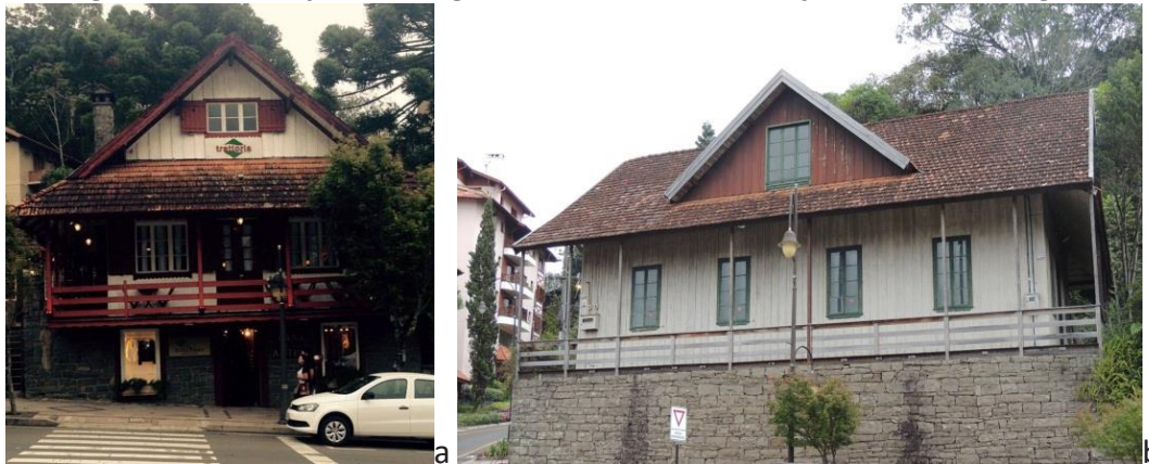
Figura 3: a) Edificação Av. Borges de Medeiros; b) Edificação Rua Emílio Sorgets.
