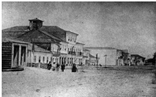
Figura 2 - Fotografia da rua Marechal Floriano próximo à esquina com Andradas – com areias e sem calçamento - no ano de 1868. Acervo: Biblioteca Rio-Grandense. Fonte: TORRES, 2018, p. 09.
