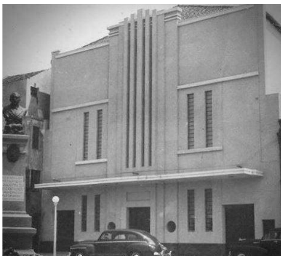
Figura 3 - Fotografia dos fundos do antigo Cine Teatro 7 de Setembro (Praça Júlio de Castilhos), Rio Grande, RS Fonte: Beira Mar 3 , 2020.
