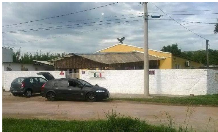
Figura 14: Fachada do terreiro CEU Ogum Sete Espadas
