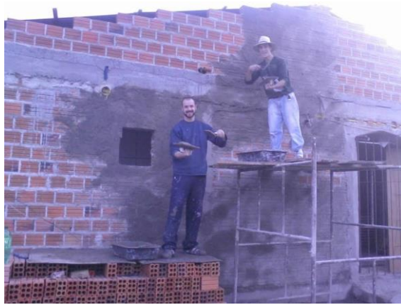
Figura 11: Dois filhos de CEU Ogum construindo o novo terreiro
