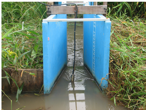
..... Figura 19: Calha Parshall e sensor de nível .....Foto: Autor
