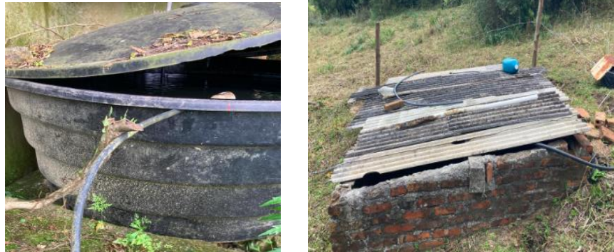
Figura 1: Reservatório/poço situado em algumas das propriedades em condições inadequadas.
