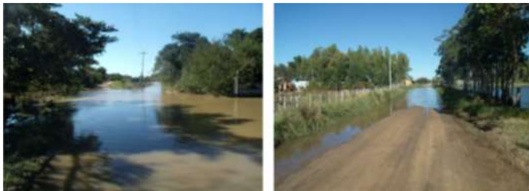
Figura 2. Estrada Travessa Maria Gomes com transbordo da enxurrada, danificando a recapagem de compactação do solo, entupimento do escoamento laterais da água e afetando a estrutura da ponte Maria Gomes.
