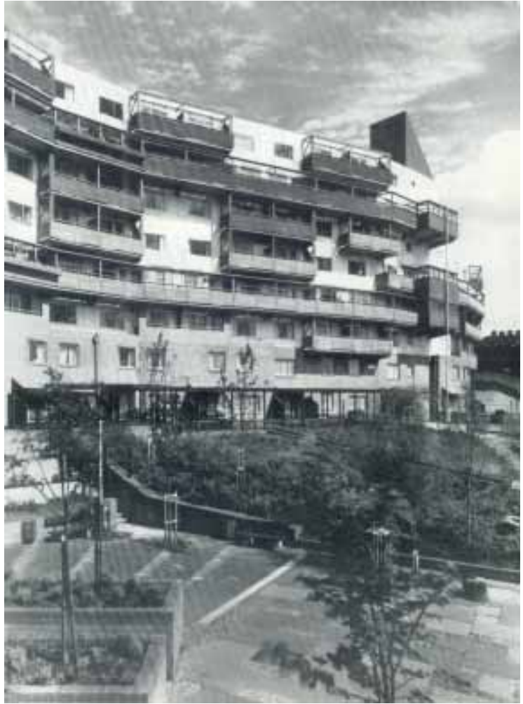
Figura 04. Projeto Byker. Vista Geral do Edifício Muro.
