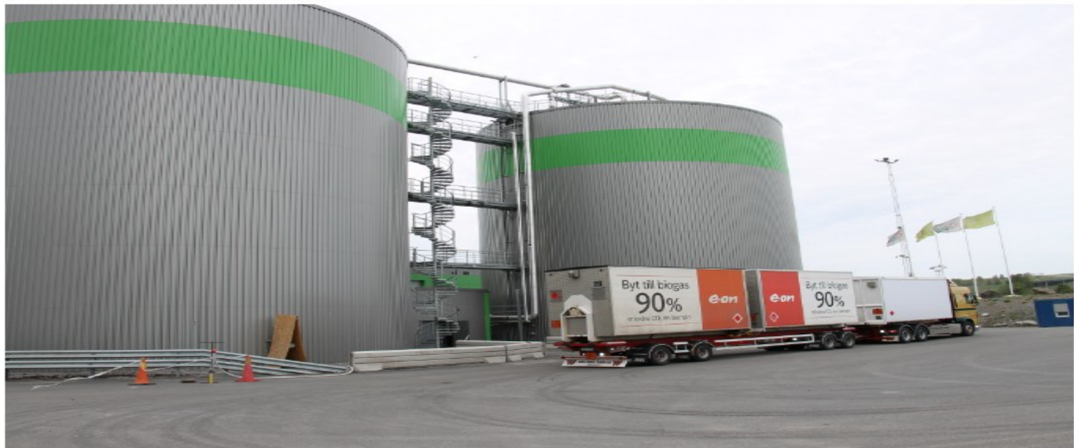
Os biodigestores da Scandinavian Biogas são capazes de processar 70 mil toneladas de resíduos alimentares para gerar biometano para ônibus, carros e caminhões. Foto: Marco Tsuyama-Cardoso
