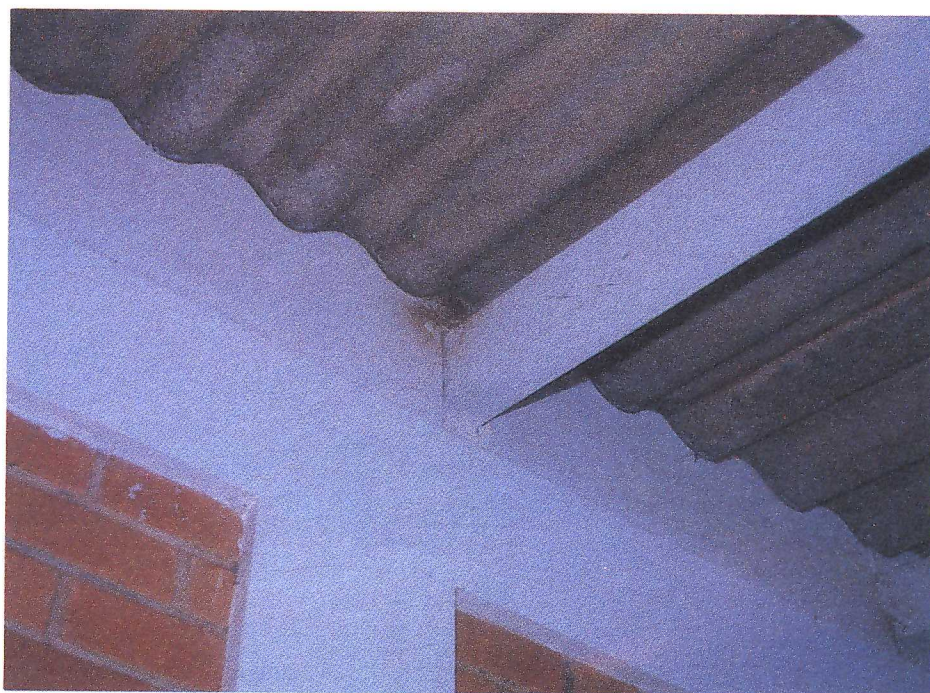
Fig.V.17. Casa residencial, em alvenaria e telhado em fibro-cimento, mostrando uma falha de construção utilizada pelos morcegos insetívoros ( Molossus molossus ) como local de entrada ao seu abrigo diurno. Note-se a mancha gordurosa (oleosidade de seus pêlos) deixada pelos morcegos ao pousar no local, antes de adentrar. (Foto: W. Uieda)
