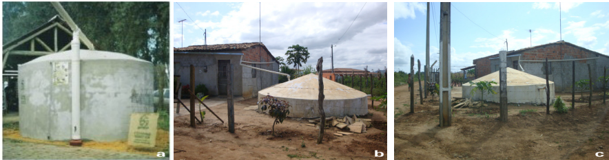
Figura 12. Reservatórios construídos em concreto armado
