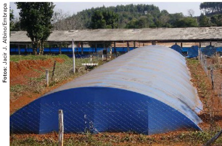
Figura 14. Reservatório em PEAD
