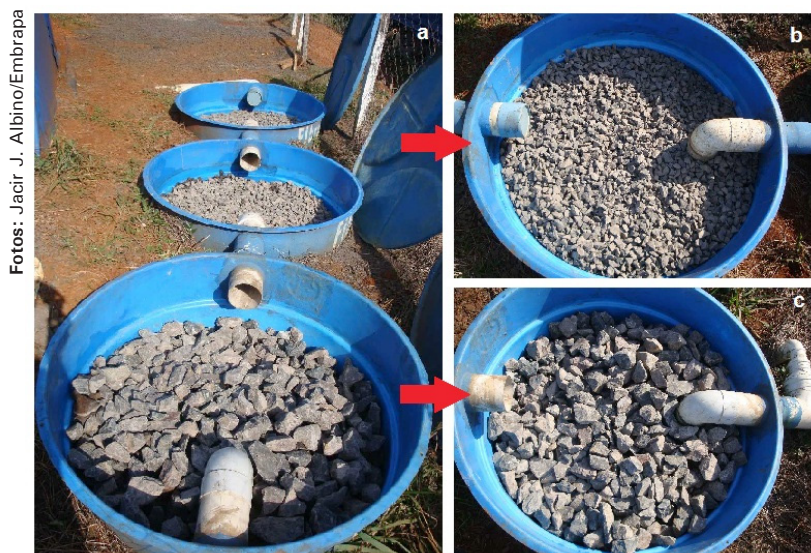
Figura 9. A. Sistema de filtração rápida em três caixas de fibra: com pedra marroada (tamanho médio de 5-6 cm, conforme detalhe Figura 9C), brita nº 2 e brita nº 1. B. Observa-se o último filtro de passagem rápida antes da cisterna, com brita nº 1.
