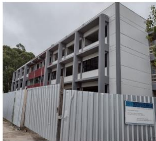
Imagem 02– Prédio da Obra Aulário Meteoro
