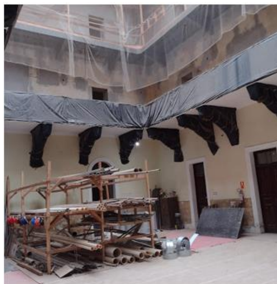
Imagem 04– Interior do prédio do Grande Hotel
