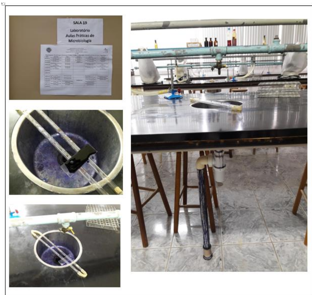
Figura 08 – Evidência de resíduos químicos líquidos.
