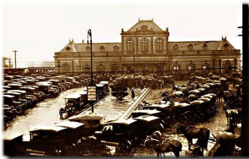
Figura 3: Esta foto da Estação de Férrea de Pelotas mostra detalhes diferenciadores, possuía na sua frente um toldo com estrutura metálica, além de suas laterais serem diferentes do modelo a ser seguido. 14
