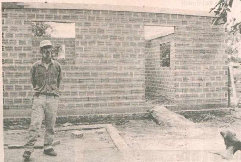
Após um ano de espera a casa de Milton Nietzsche está sendo construída
