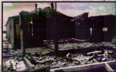
CTG destruído pelo fogo
