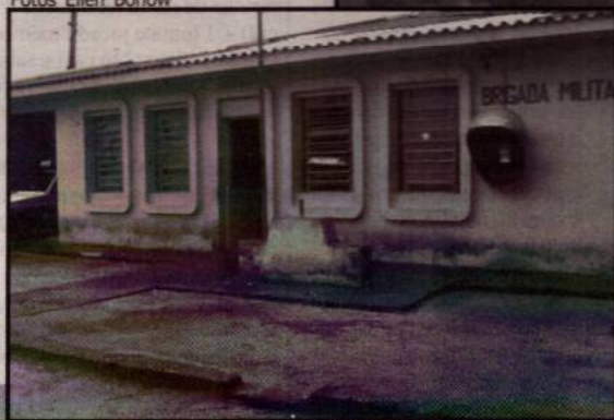
O posto policial raramente está aberto. No detalhe, adesivo com informações na porta do prédio da PM.
