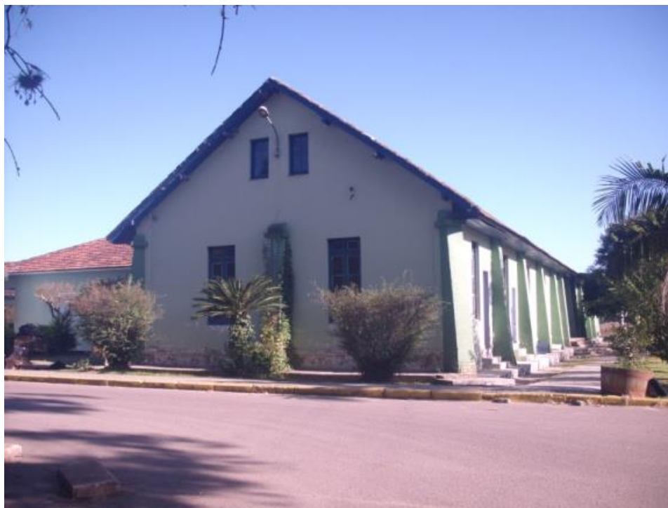
Figura 7 - Prédio carinhosamente conhecido como pulga . Atualmente, neste espaço concentram-se salas de aula e um auditório. Fonte: acervo pessoal do autor.
