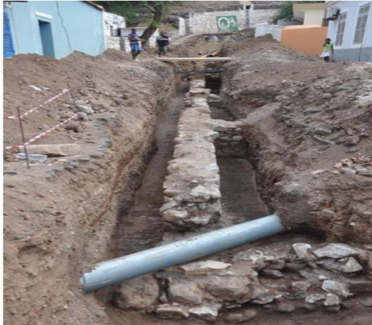
Figura 9 – Estruturas antigas – Rua Calhau Fonte: Evans; Stig Sorensen (2010, p.06).
