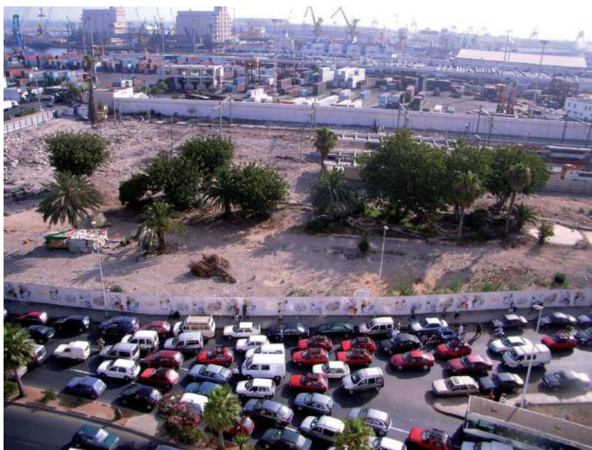
Figura 51 - Aspecto de tecido urbano de Casablanca incluindo rede viária, espaços abertos e tecido edificado.
