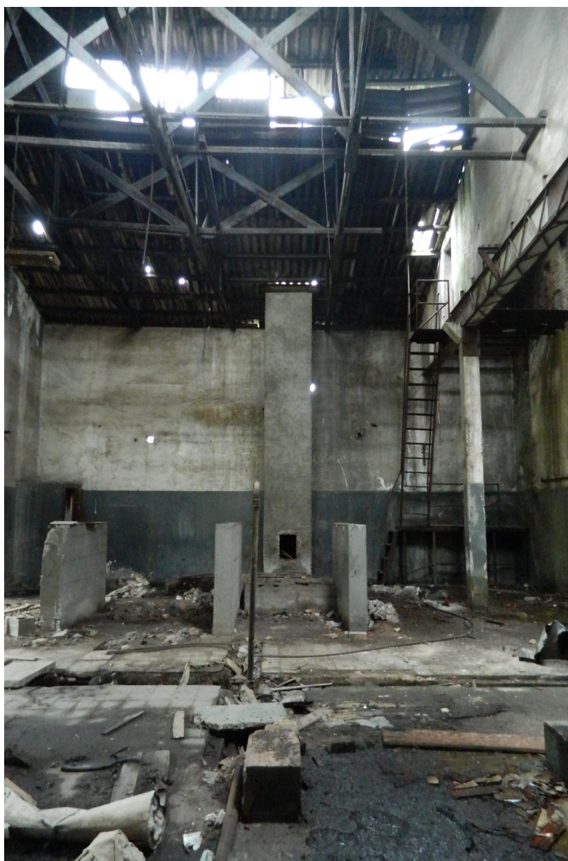
Figura 17: Antigo setor de caldeiras – Laneira Brasileira S.A. Destruição das estruturas de apoio do reservatório de água quente e estruturas de piso. Ação de agentes químicos e biológicos, e acúmulo de umidade. Foto: Autor/2013.
