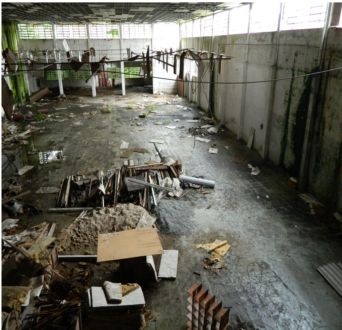
Figura 16: Antigo setor de fiação – Laneira Brasileira S.A. Infiltração e acúmulo de umidade, ação de agentes biológicos, destruição do forro, e resto de material da fábrica. Foto: Autor/2013.
