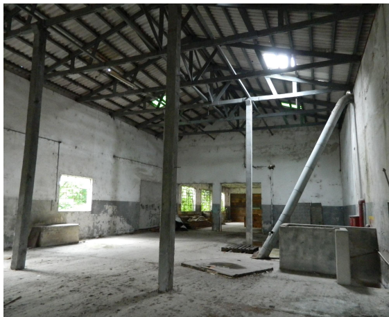
Figura 22: Vista do depósito de lã inferior, onde encontra-se a tubulação que conduz a lã do sub-solo até o outro prédio. Fonte: Autor/ 2013
