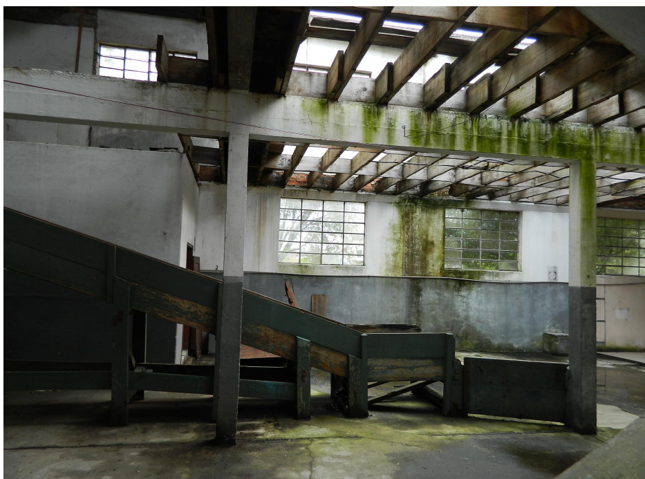
Figura 13: Antigo setor administrativo – Laneira Brasileira S.A. Ação de agentes biológicos e acúmulo de umidade devido à ausência de cobertura. Foto: Autor/2013.
