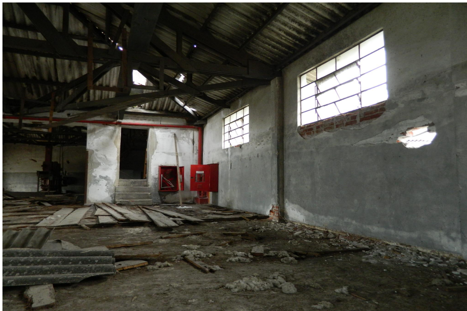
Figura 14: Antiga “praia de lavanderia” – Laneira Brasileira S.A. Desprendimento do revestimento do piso devido à umidade proveniente das falhas na cobertura. Foto: Autor/2013.
