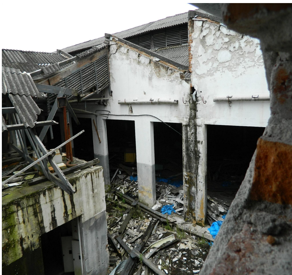
Figura 15: Pátio interno – Laneira Brasileira S.A. Destruição da cobertura e das tubulações de coleta pluvial, e desgaste das argamassas de revestimento. Vista a partir do buraco na parede (ver figura 4). Foto: Autor/2013.
