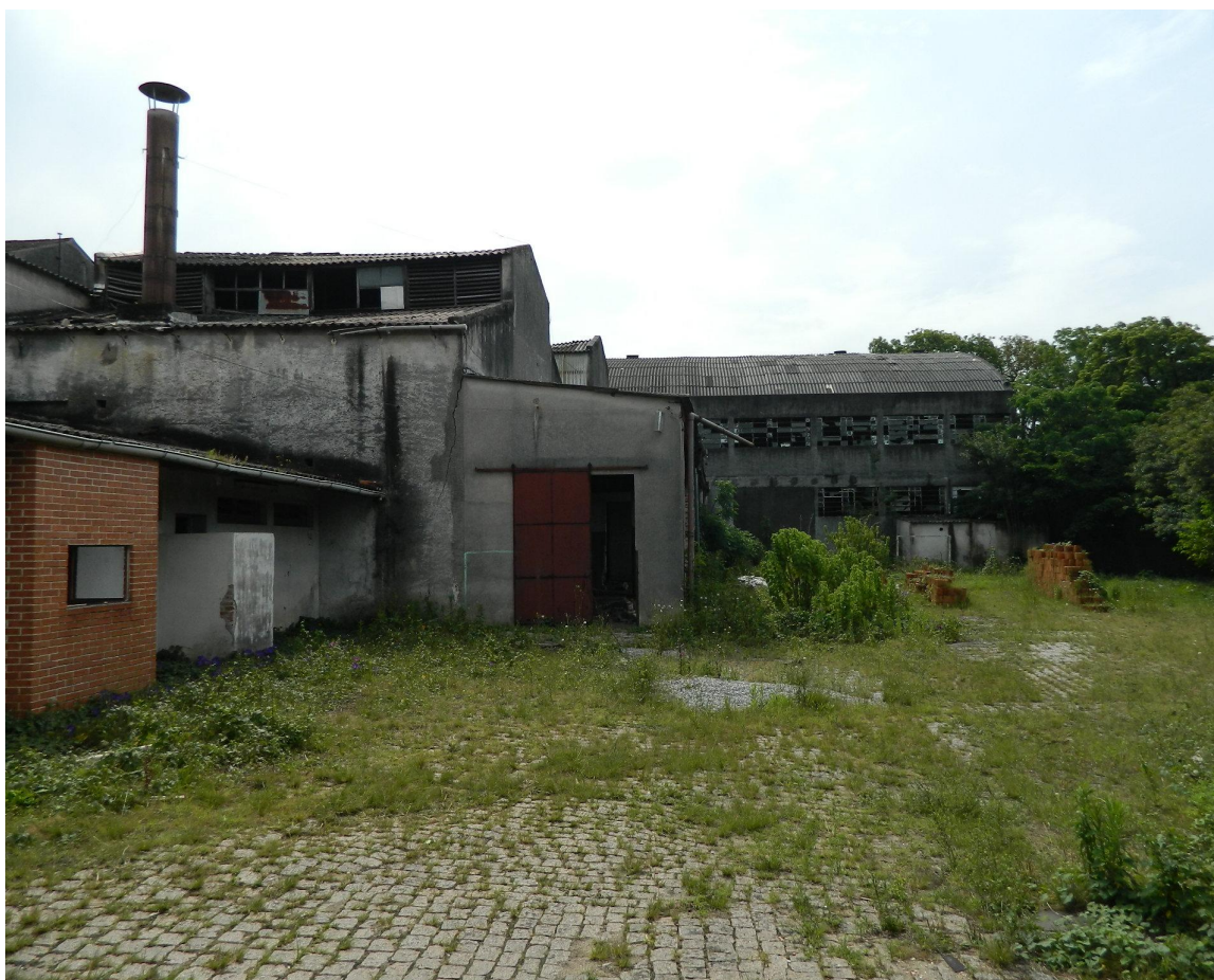
Figura 18: Pátio dos fundos – Laneira Brasileira S.A. Vidraças quebradas permitindo a entrada de umidade no interior do prédio. Falta de manutenção geral do prédio. Foto: Autor/2013.
