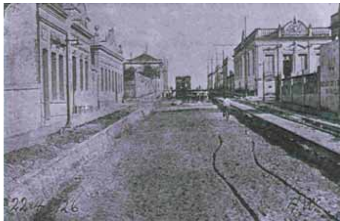
Figura 3 - Rua Benjamin Constant pavimentação e instalação dos trilhos
