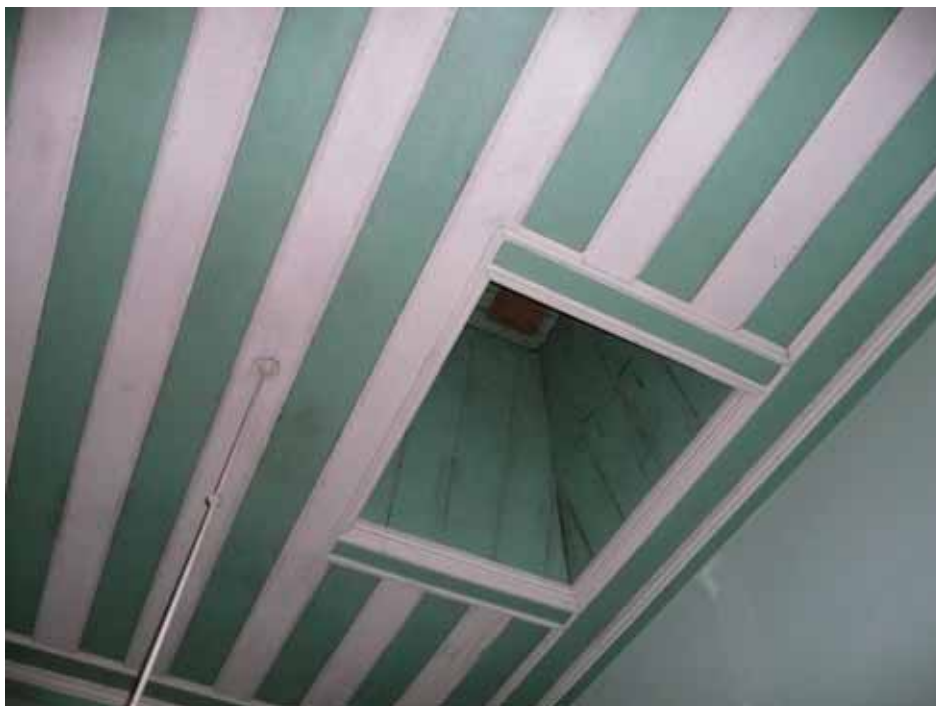
Figura 32 – Sistema de exaustão semelhante às coifas contemporâneas. Fonte: Arquivo pessoal, 2007.
