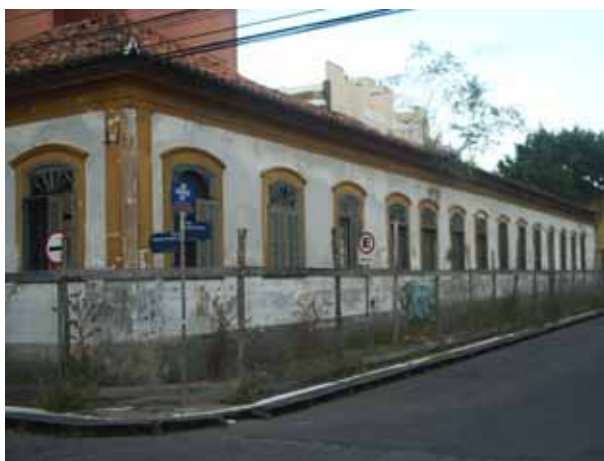
Figura 22 – Foto de Rafael da R. Guterres. Casarão dos Mendonça. Localizado no primeiro loteamento na divisa com o segundo.
