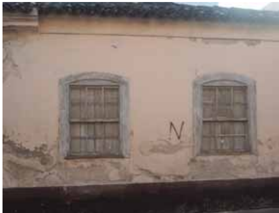
Figura 13 – O prédio mais antigo de Pelotas (detalhe das janelas) – foto de Rafael da Rocha Guterres. Observa, no detalhe, das janelas, o estilo português na forma de guilhotina. A madeira de lei, resistente à intempérie.
