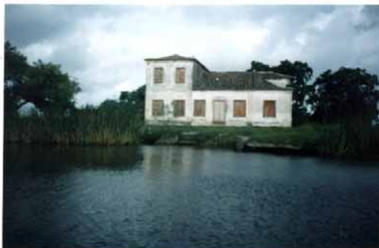
Figura 18 – Antiga charqueada de José Antônio Moreira. Foto do autor. A antiga charqueada que pertenceu ao Barão de Butuy se encontra em total estado de abandono. Um patrimônio que, ao longo do tempo, encontra a destruição pelas intempéries e pelo vandalismo, sorte que o referido edifício situa-se numa área de difícil acesso. Comparando com fotos mais antigas, nota-se que o estado de conservação está cada vez pior. É lamentável. Hoje, pertence a herdeiros da família Aranal di, mas que não residem em Pelotas.
