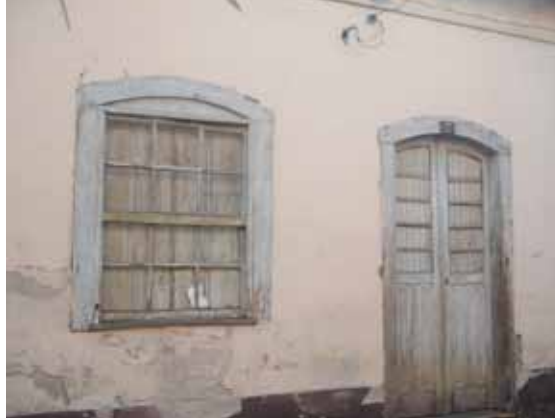
Figura 12 - Edifício mais antigo (detalhe porta e janela). Foto: Rafael da Rocha Guterres. Construído em 1831, no sítio urbano planejado, primeiro loteamento na rua Major Cícero entre Anchieta e Gonçalves Chaves. As figuras 12, 13 e 14 estão relacionadas ao prédio colonial. Na foto 12, pode ser visto um edifício do verticalismo (representa poluição). Como pode ser visto, numa forma rudimentar, a madeira de lei, utilizada na época é resistente para enfrentar as condições meteorológicas do clima de Pelotas, do clima subtropical 9
