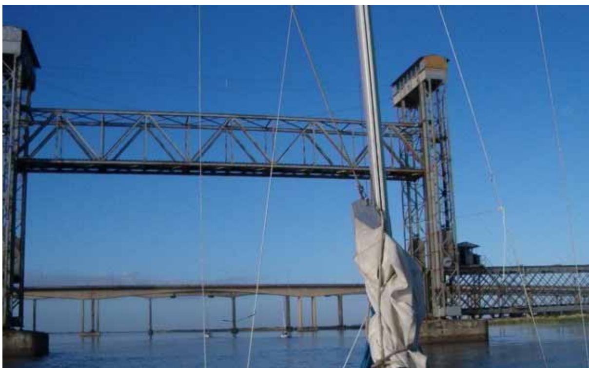
Ilustração 23 – Detalhe da ponte em ferro no Canal São Gonçalo , Pelotas, RS. Fonte: Acervo Sanep, 2006
