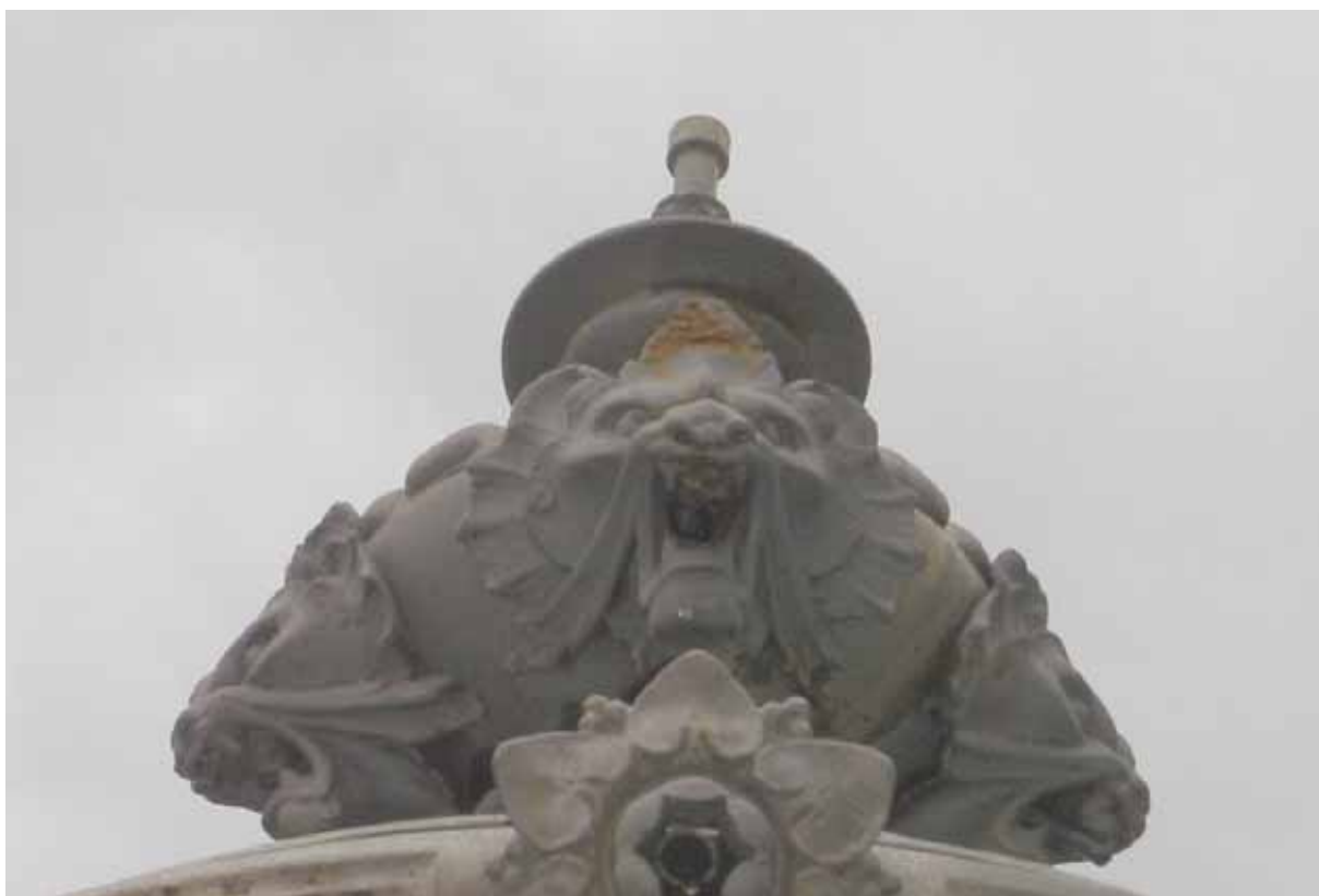
Ilustração 67 – Ponteira do chafariz do Calçadão. Fonte: Foto da autora, 2006.
