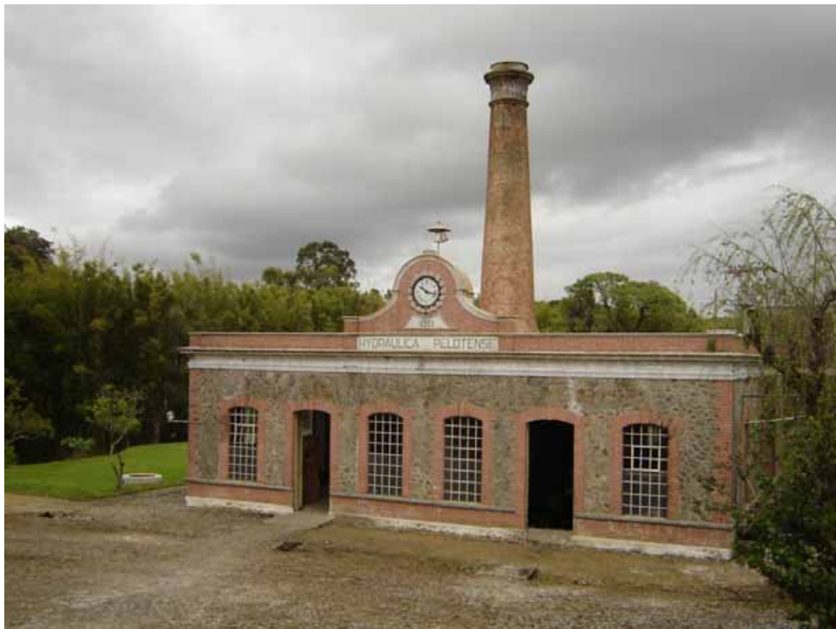
Ilustração 24 – Casa de Bombas da Estação de Tratamento de Água do Moreira , Pelotas, RS. O relógio, no alto do prédio, veio de Paris e continua em funcionamento. Fonte: Foto da autora, 2006
