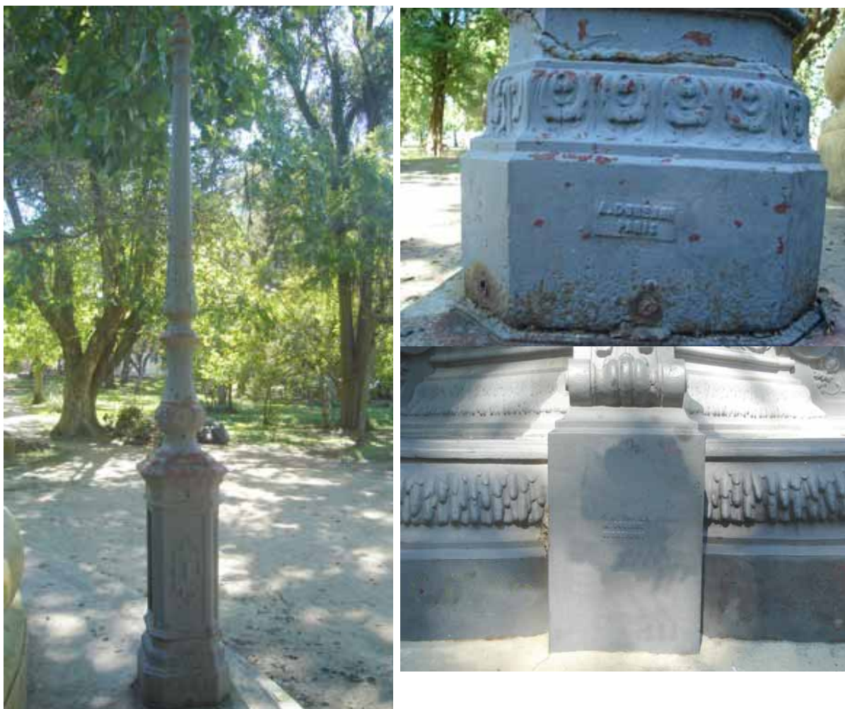
Ilustração 81, 82 e 83 – Poste do Chafariz da Praça Cypriano Barcellos e detalhes do poste e da base e do chafariz com a inscrição da fundição Durenne.
