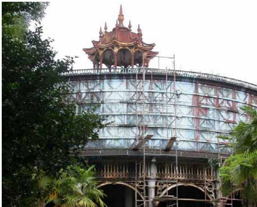
Ilustração 92 – Detalhe das paredes externas do Reservatório da Praça Piratinino de Almeida. Fonte: Acervo do Sanep, 2004.
