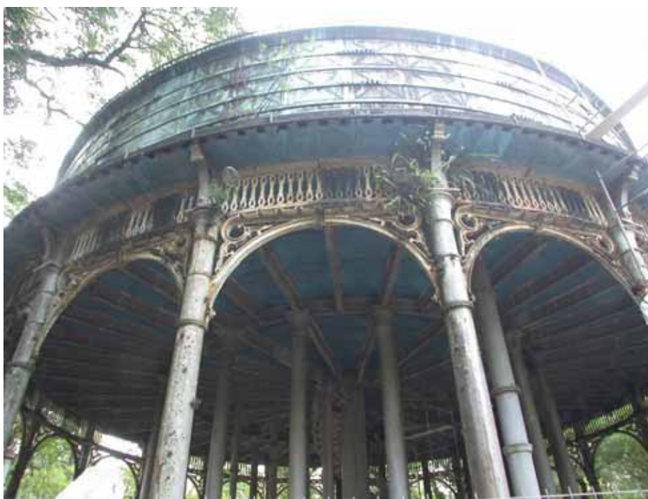
Ilustração 91 – Detalhe das colunas e dos ornamentos do Reservatório da Praça Piratinino de Almeida. Fonte: Acervo do Sanep, 2004.
