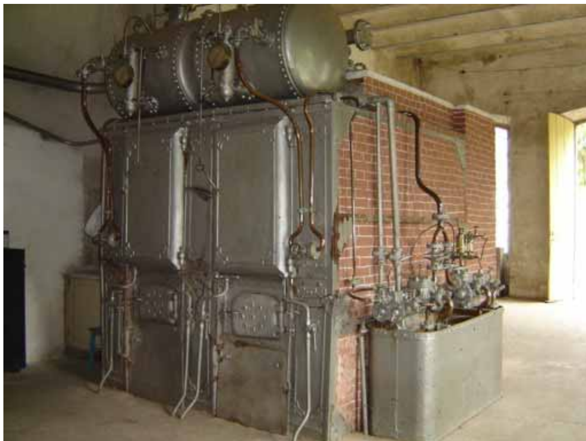
Ilustração 28 – Forno a vapor da Estação de Tratamento de Água do Moreira, Pelotas, RS. Fonte: Foto da autora, 2006.
