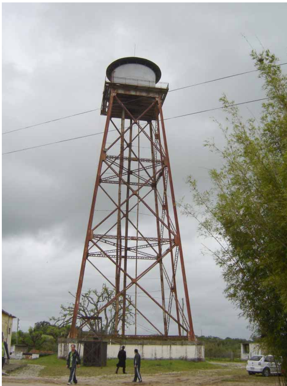
Ilustração 89 - Foto do Reservatório em ferro do Moreira vindo de Paris, 1892.
