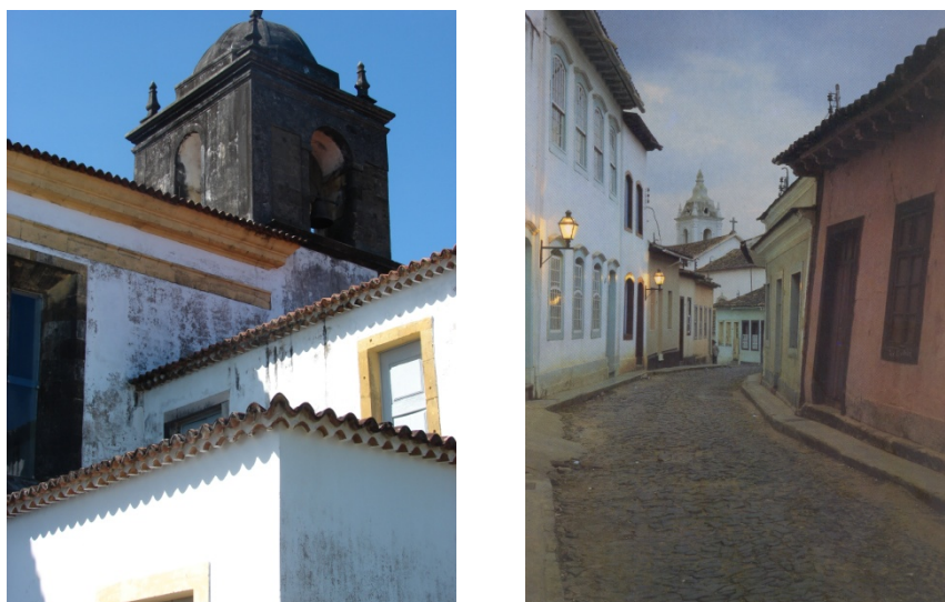
Figura 2: Na imagem à esquerda: Beirais do tipo beira sob beira e cimalha ornamentada com cornijas, Olinda/PE. Fonte: Foto da autora, 2009. Na imagem à direita: Beiral com cachorros de madeira, tanto na casa térrea como no sobrado da arquitetura de São João Del Rei/MG Fonte: ALVES, Leila. São João del Rei. Rio de Janeiro: SPALA, 1995. p. 44.
