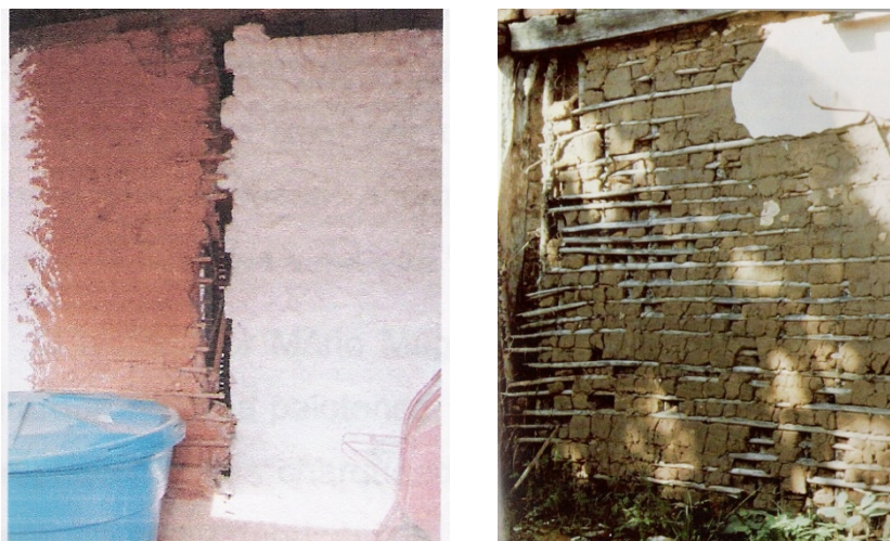
Figura 3: Na imagem à esquerda: Parede na técnica de pau a pique. Tiradentes/MG. Fonte: Foto cedida por Carlos Alberto Ávila Santos. Na imagem à direita: Parede na técnica pau a pique. Fonte: IPHAE, Patrimônio Edificado, Orientações para sua preservação. Porto Alegre: Corag, 2004. p. 45.
