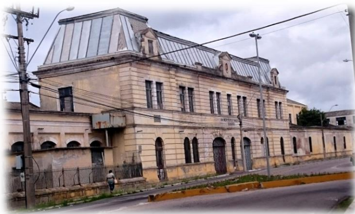
Figura 5: Entrada Principal do Complexo Rheingantz Fonte: Arquivo Pessoal
